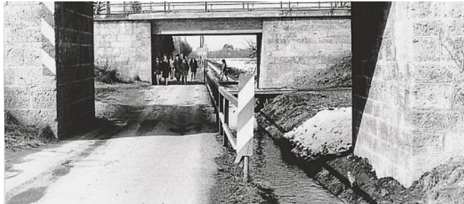
Der Ascherbach in den Bahnunterführungen im März 1973
