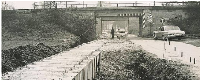
Verrohrt im November 1973
